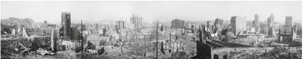
Zerstörungen in San Francisco durch das Erdbeben von 1906
