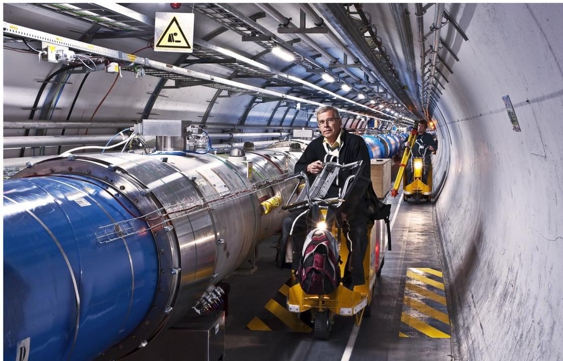
Der LHC Tunnel: Beam-Rohr und Magneten.
